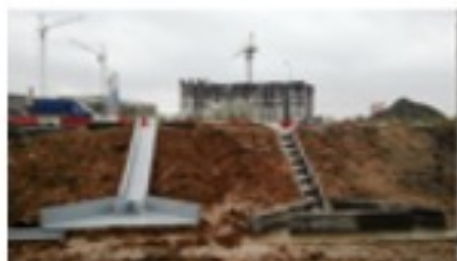
Легкие, некорродирующие лотки для водоотведения
