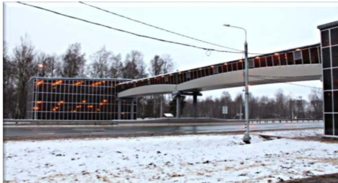
МОСТЫ И ДЕКИ ПОЛНОСТЬЮ ИЗ КОМПОЗИТНЫХ МАТЕРИАЛОВ, НО С ТРАДИЦИОННЫМИ ОПОРНЫМИ КОНСТРУКЦИЯМИ.
